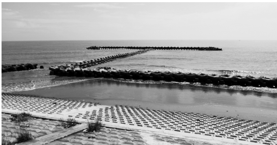
Рис. 5. Типичный комплекс берегозащитных и пляжеудерживающих конструкций (2014 г.)
