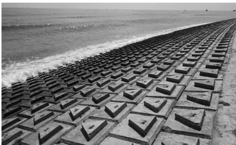
Рис. 3. Типичная волногасящая откосная стенка с мористой стороны дамбы (2014 г.)
